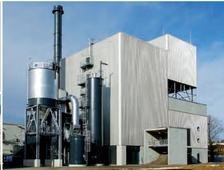
CO<sub>2</sub>-neutrale Wärme- und Stromproduktion in Kraft-Wärme-Kopplung durch Einsatz von Biomasse
